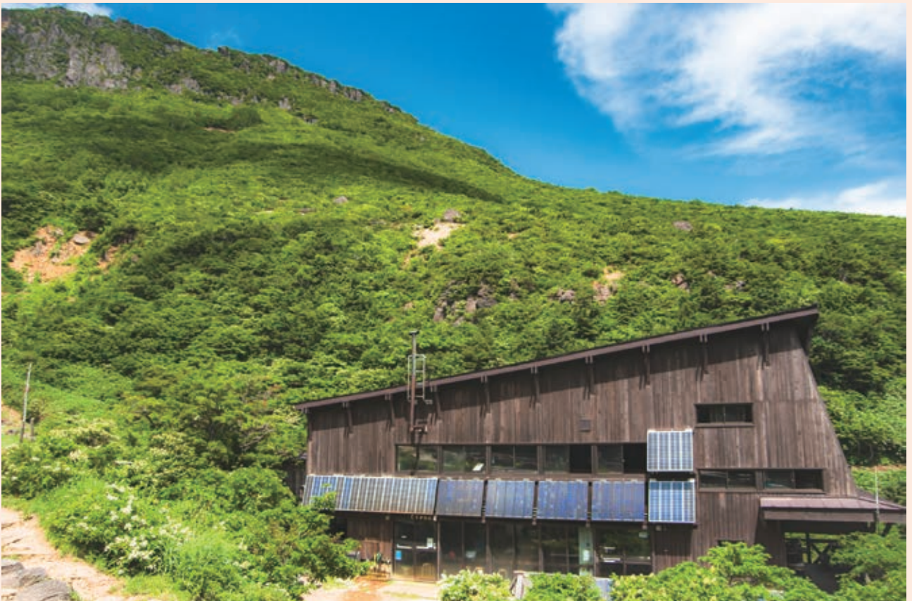
くろがね小屋（現在建て替え中）（安達太良山）
