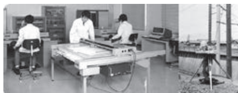
左：解析図化機プラニコンプC-100 右：1970年北九州市小倉駅構内での平板測量
