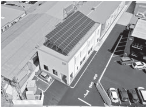
高効率帯水層によるトータル熱供給システムを導入した『ZEB』実証施設（日本環境科学（株）本社）
