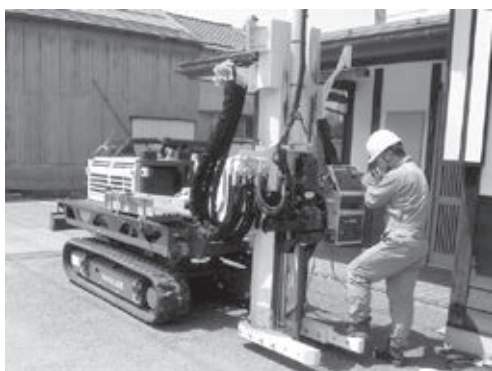
ジオプローブを使用した試料採取ボーリング
