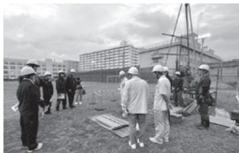
定時制の建築土木科のボーリング実習の様子
