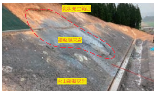
写真-1 崩壊発生前ののり面状況
