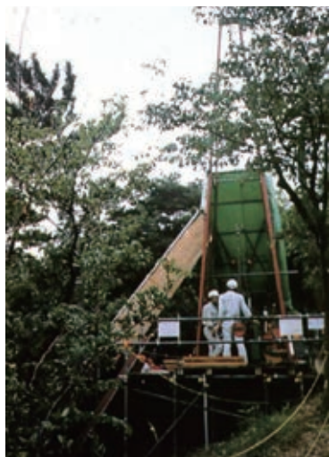
図18 機械ボーリング (全地連HP写真集P6)
