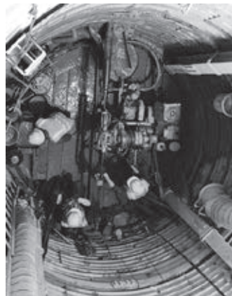
ベトナムでの集水井工事
