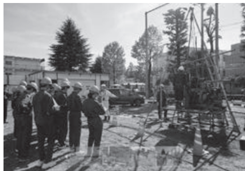
全日制の土木科のボーリング実習の様子
