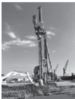
写真1 SAVEコンポーザー工法
