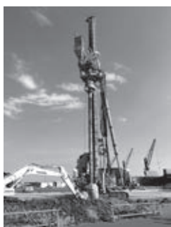
写真1 SAVEコンポーザー工法
