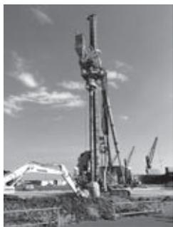
写真1 SAVEコンポーザー工法
