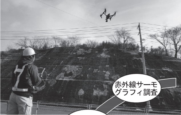
《ドローンを活用した赤外線サーモグラフィ調査》
