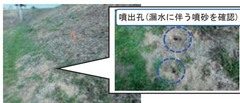
写真-1 漏水箇所①のり尻の噴砂跡
