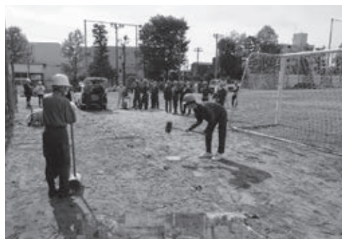
全日制の土木科の表面波探査実習の様子
