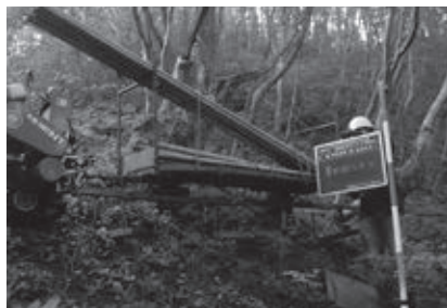
モノレールによる資材運搬
