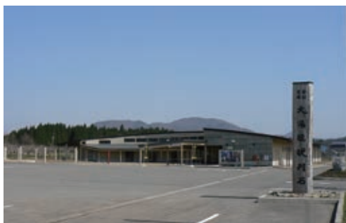
写真11 大湯ストーンサークル館外観
