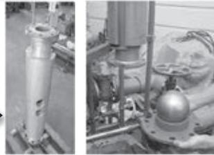
◆同一の井戸で揚水・還元を内部球の上下移動により切替運用できる弁の開発をした。
