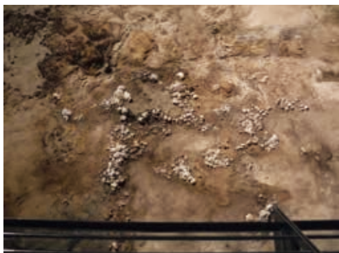
析出している塩類（硫酸マグネシウム）
