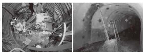
高角度排水ボーリングとトンネル内排水状況
