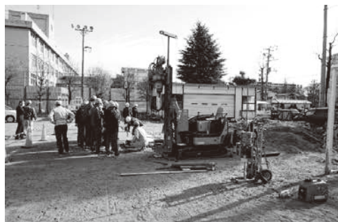
令和2年 土木科 ボーリング実習
