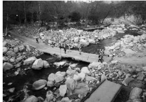
写真-2 stop3 丸森町不動 巨石が点在する内川と被災した遊歩道
