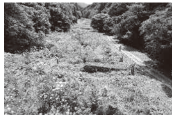
砂防施設（正法寺川）石造堰堤
