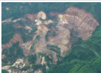
2008 岩手・宮城内陸地震 荒砥沢ダム上流の大崩落 出典：東北地方整備局資料
