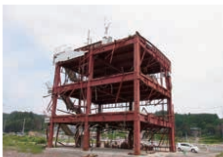
2011 東日本大震災 南三陸町防災対策庁舎
