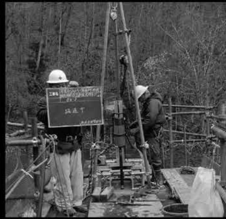
砂防堰堤上でのコアドリルによる コアボーリング状況(15m程度可能)
