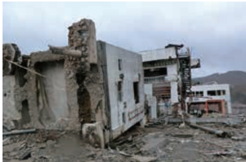
写真-2 女川町でのコンクリート建物被害(著者撮影)
