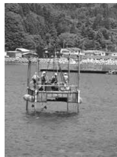
海上ボーリング
