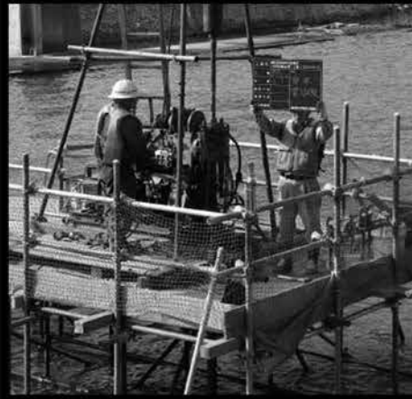
海上ボーリング状況
