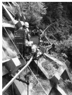
モノレール架設
