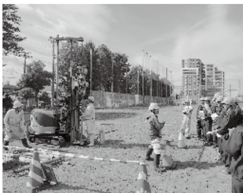
ボーリング実習状況
