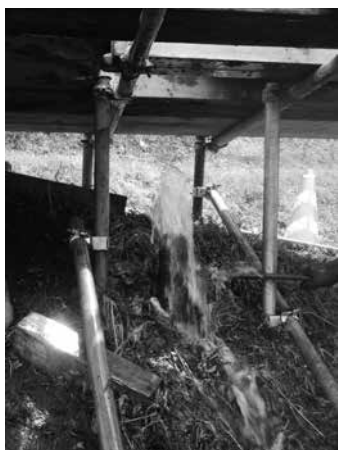
ボーリング孔からの湧水
