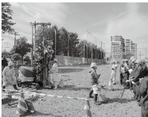
ボーリング実習状況
