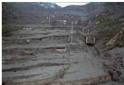
写真2 有珠山2000年の噴火による地殻変動。地下に貫入した溶岩によって国道が階段のようになっている。
