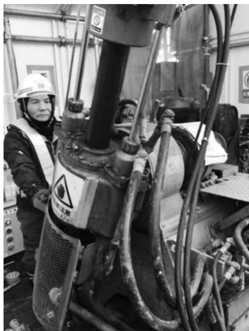
斜め φ116 mm オールコア L=120 m予定 作業状況
