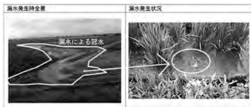
写真-1 基盤漏水発生箇所の状況
