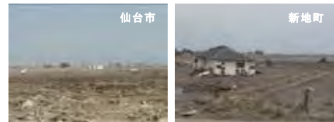
住宅等の被災
