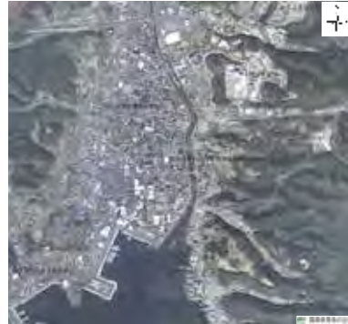
地震発生前(2009.5)の気仙沼港の様子
