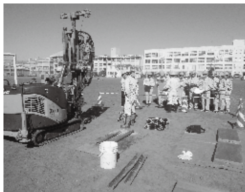
ボーリング実習状況
