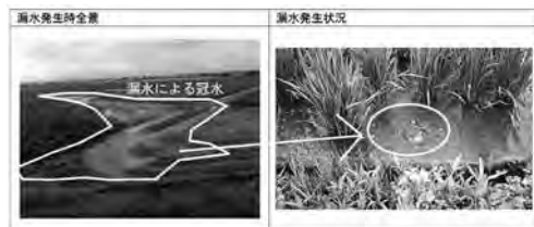
写真-1 基盤漏水発生箇所の状況
