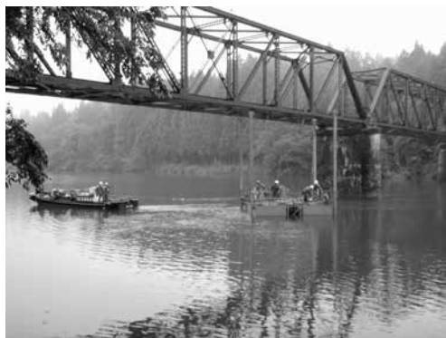
【廃橋をくぐり曳航するスパッド台船】
