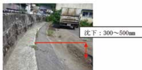
写真-1 沈下状況(左岸ボーリング地点A)
