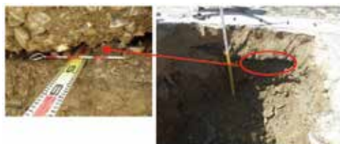
写真-2 浅層部の空洞化状況(右岸ボーリング地点B)
