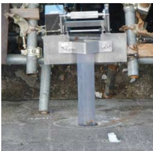
写真-3 透明保孔管設置状況
