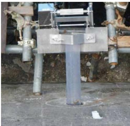
写真-3 透明保孔管設置状況
