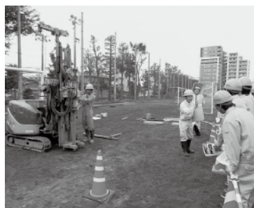
ボーリング実習状況
