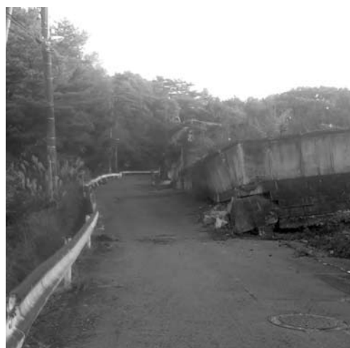
仙台市折立団地の被災状況
