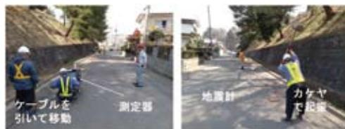
写真-1 表面波探査測定状況
