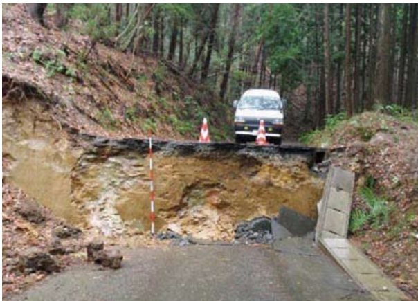
写真13 2011年4月11日の地震により地表に現われた地震断層 いわき市田人町 写真は品川ほか(2011)より引用
