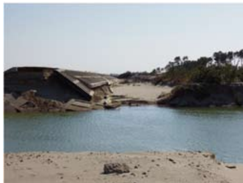
写真-9 津波により破壊された防潮堤 背面(右側)が津波により抉られている。手前の水域は 写真-8の浸食部に同じ。 (仙台市若林区荒浜・図-2左下参照)
