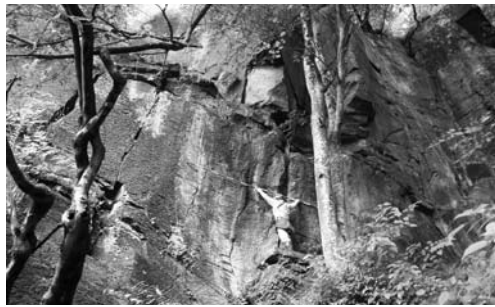
写真.1 落石対策の調査中
