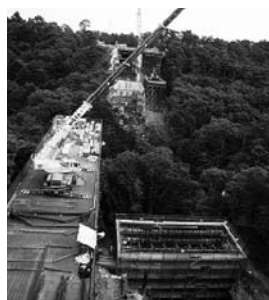
竜の口橋梁施工状況 (川青葉山トンネル側から臨む)
