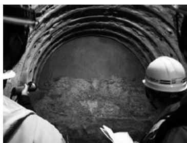
亀岡トンネル切羽状況 (川内側坑口から800m付近)
