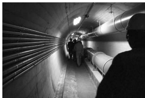
廃坑道からパイプで導水される坑内水(約300mのトンネルを歩いて湧出口を見学)
