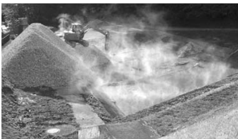
沈殿池での石灰投入作業
