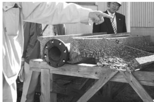
松尾鉱山の強酸性水によって腐食したコンクリートとパイプ
