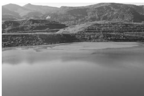
沈殿池と、その後ろに見える八幡平地すべり
