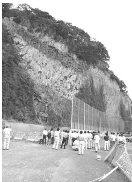
写真-11 平成16年の地震で住民が避難した岩盤崩落危険箇所 (今でもオーバーハングした不安定岩塊が見られ、対応策に議論が集中)
