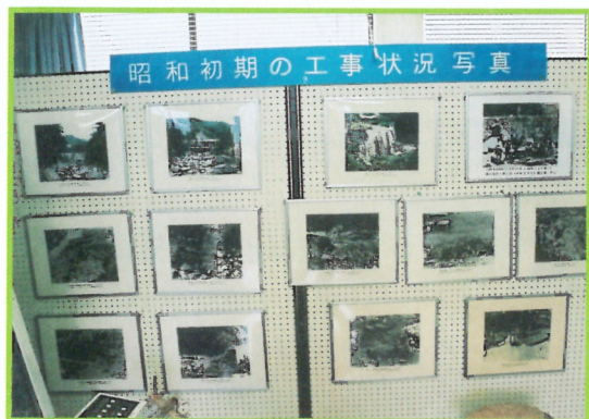
写真3 砂防ダム施設コーナー
