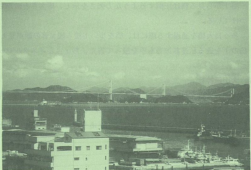
来島海峡SAより望む来島海峡大橋
