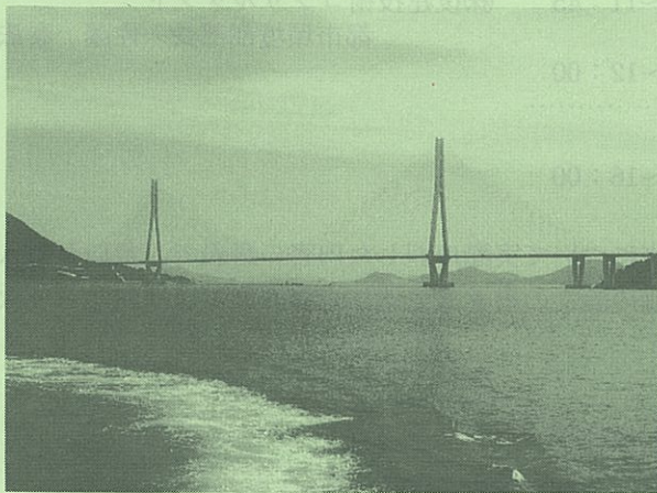
多々良大橋（橋長1,480m、中央支間長890m）
