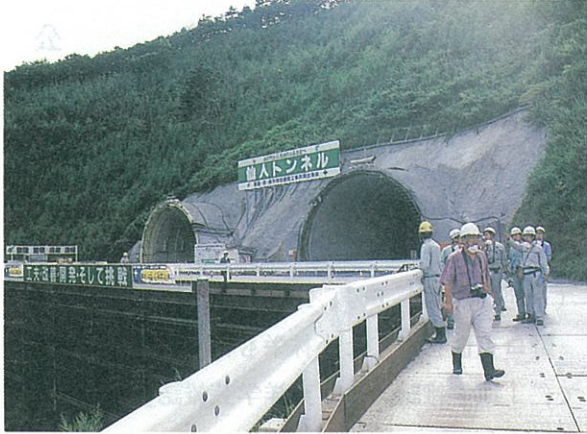
急峻な山腹に取り付けられた、仙人トンネルの坑口
