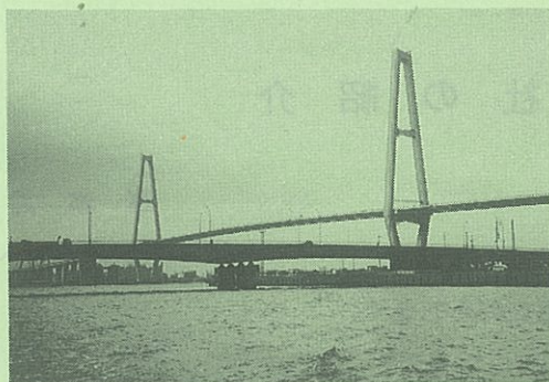
名港東大橋 橋長700m 塔高130m
