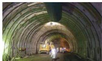
トンネルの工事は深い場所での作業になります。掘り進めていく過程で予定外の出水に遭遇するリスクもあります。このため地質調査を掘削工事と同時進行することで、安全と高効率を実現します。
