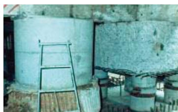
写真 4 仙台市太白区の市営住宅(左)と 1978 年宮城県沖地震後の基礎部の補強 13) (右)
