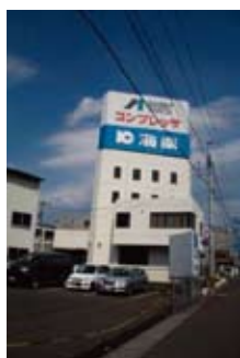
写真5 傾斜したRC造4階建て杭基礎建物 (左) 全景 (右) 沈下した南東端柱脚部
