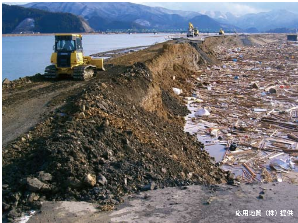
北上川下流左岸 2.5k付近、一部堤防が消失。堤防復旧状況。 平成 23 年 3 月 16 日撮影
