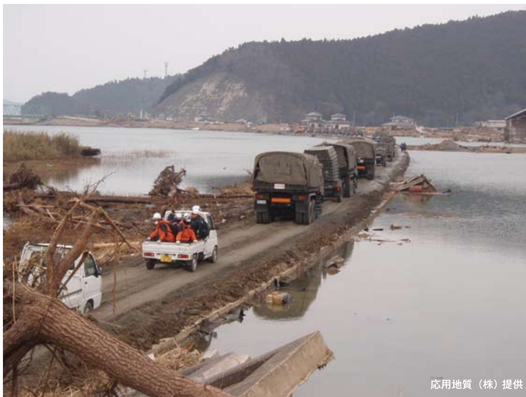
北上川下流右岸5k付近 津波で堤防が消失 平成 23 年 3 月 21 日撮影
