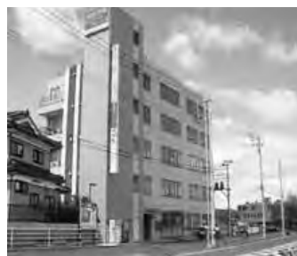
東北支店 （5階の一部）
