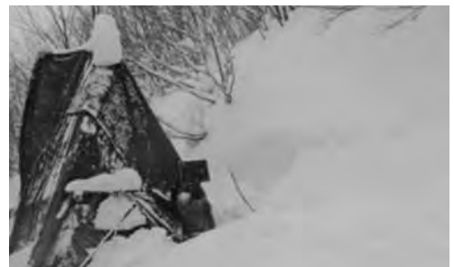
某ダム現場における厳冬期でのボーリング作業状況
