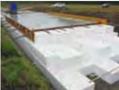
写真-1 EPS設置状況
