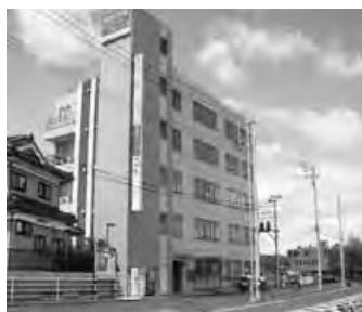
東北支店 (5階の一部)
