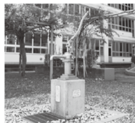
※2016年に山形県さく井技術協会が寄贈し、山形二中に設置された手押し式の防災井戸。
