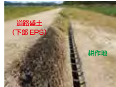
写真-2 盛土後状況
