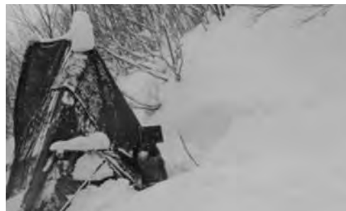
某ダム現場における厳冬期でのボーリング作業状況
