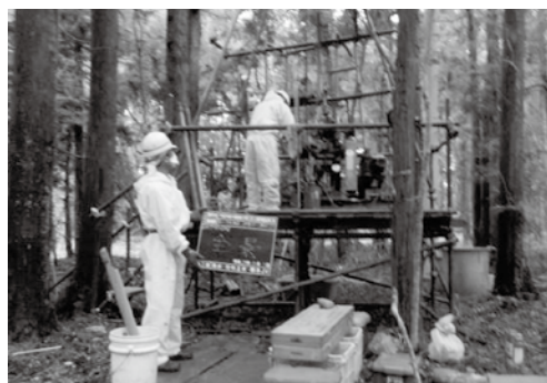
中間貯蔵(大熊地区)のボーリング作業状況
