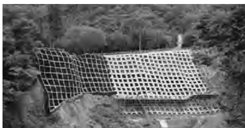
NMグラウンドアンカー
