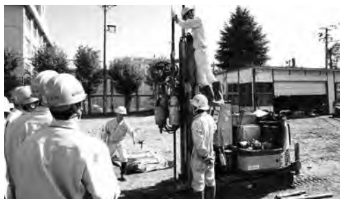
ボーリング実習(標準貫入試験)
