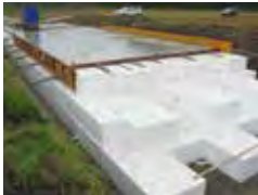
写真-1 EPS設置状況
