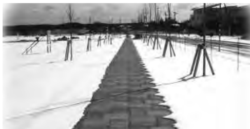
地中熱ヒートパイプ融雪システム
