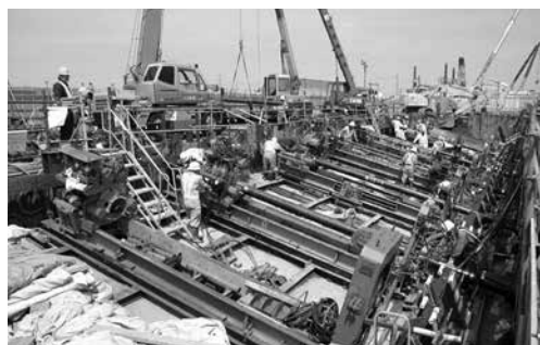
【小口径推進現場】
