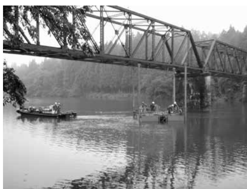
【廃橋をくぐり曳航するスパッド台船】
