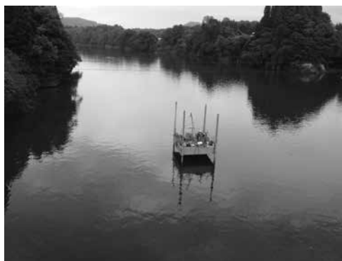
【ボーリング作業状況】
