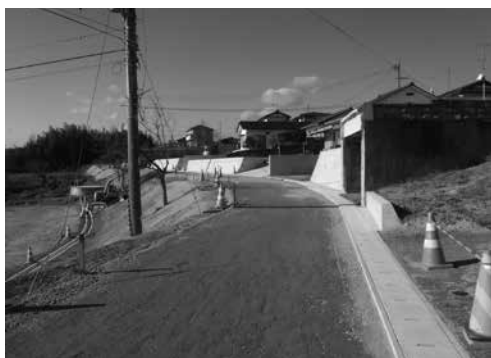
【調査を担当した震災時造成宅地の被害と復旧状況】
