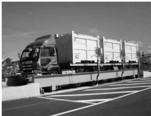
写真-4 空間線量率高速計測システムを設置した搬出ゲート
