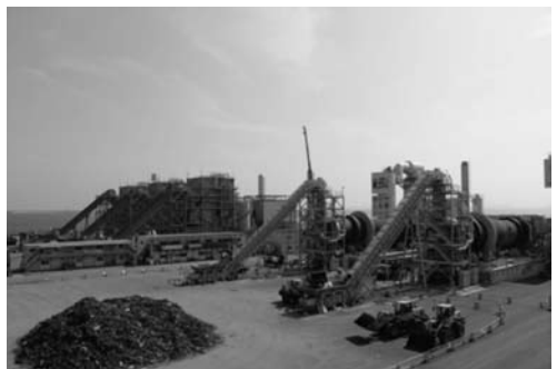
写真-2 手前 焼却炉(ロータリーキルン 処理能力300t/日、2基) 奥 焼却炉(ストーク 処理能力330t/日、3基)
