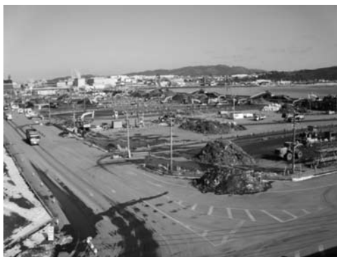
写真-3 粗選別の状況 ここで毎日約3,000トンの災害廃棄物が処理される
