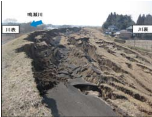
写真-1 鳴瀬川下中ノ目地区の被災状況
