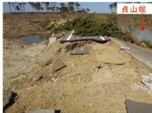
写真-10 津波侵食による盛土の破損 真山堀沿いの堤防(サイクリングロード)の舗装等表層が 津波により剥がされている。内陸側が侵食され窪地となっ ている。 (仙台市若林区荒浜・図-2)
