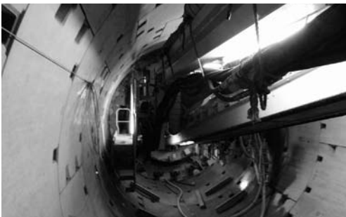
写真1 木ノ下トンネル現場
