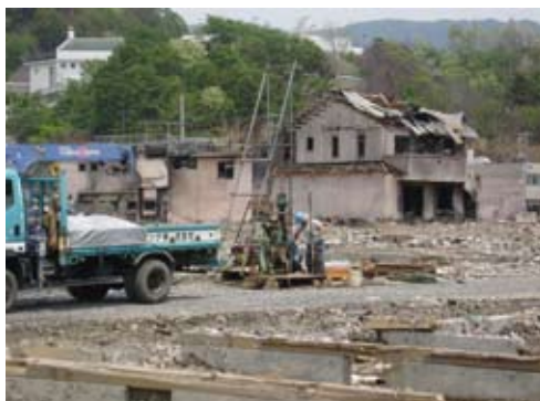
大槌町での調査ボーリング作業
