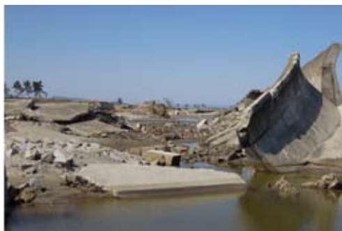
写真-12 津波による防潮堤背面の侵食 防潮堤背面が溝状に侵食される。倒壊する防潮堤手前の水域は侵食により形成された窪地。 (宮城県亘理郡山元町磯浜漁港)
