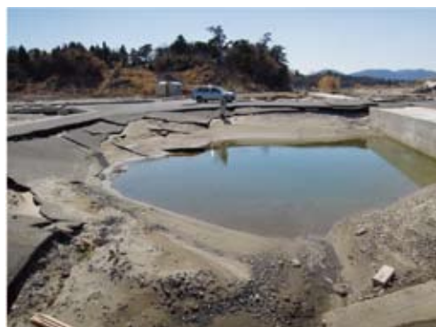
写真-11 津波による漁港の舗装面の浸食 津波により窪地状に浸食される。 (宮城県巨理郡山元町磯浜漁港)
