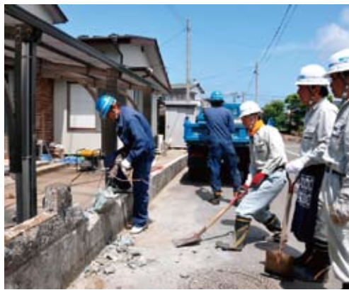
ボランティアで多賀城市内でのブロック塀解体処理作業中
