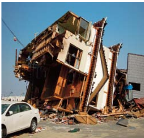
写真-9 津波被害を受けた民宿 (宮城県女川町小屋取)
