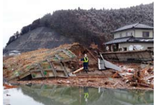
写真-3 津波によって消失した堤防
