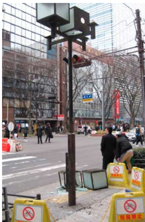
写真-6 仙台市青葉通りの地震後の状況
