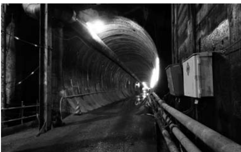
写真2 西公園トンネル現場
