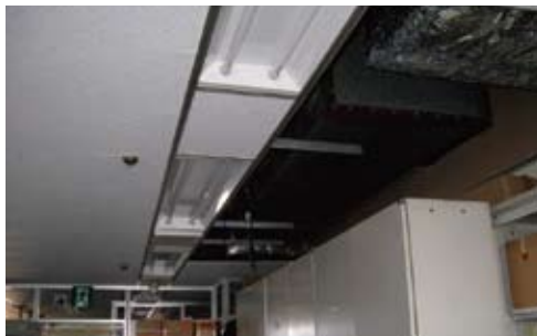
写真-3 事務所天井の一部が落下した。
