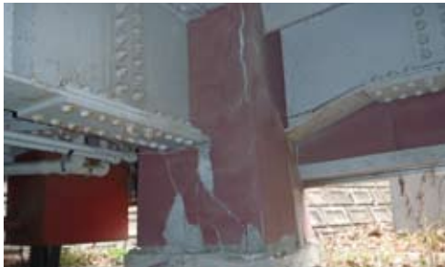
社屋基礎の被災 2
