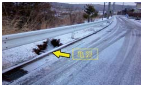
写真1：自宅周辺の亀裂
