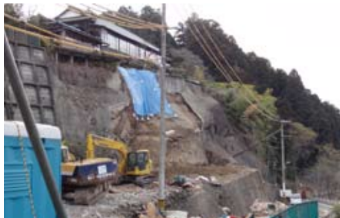
写真2 鹿落坂の斜面崩壊4月24日撮影。鹿落坂断層は養生シート手前のモルタル吹きつけ部と推定。木造家屋は撤去されている。
