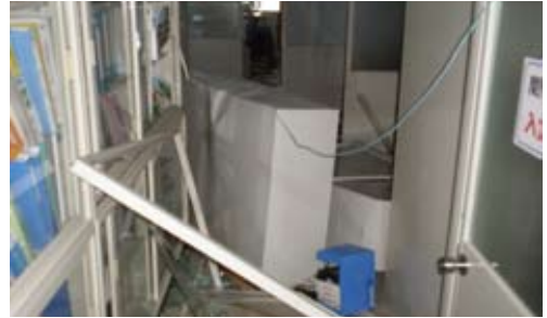
社内倒壊した棚、間仕切戸ガラスの破損
