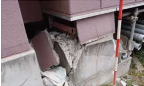
社屋基礎の被災
