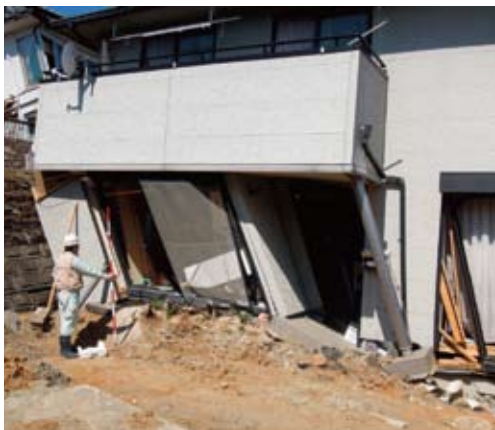
写真-7 地震時の地すべりによる住宅被害 (仙台市青葉区折立)
