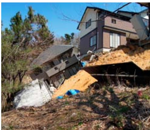
写真-8 地震時の斜面崩壊による住宅被害 (仙台市青葉区西花苑)
